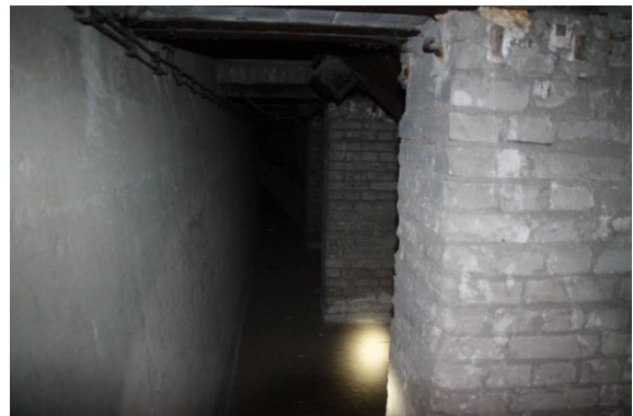
F. 6: Kellerräume im westlichen Teil der Halle
