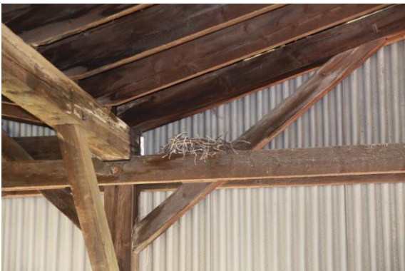
F. 5: Gebälk der inneren Lagerhalle mit Nest
