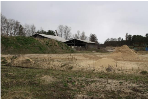
F. 3: Ansicht nach Südosten mit Lagerhalle
