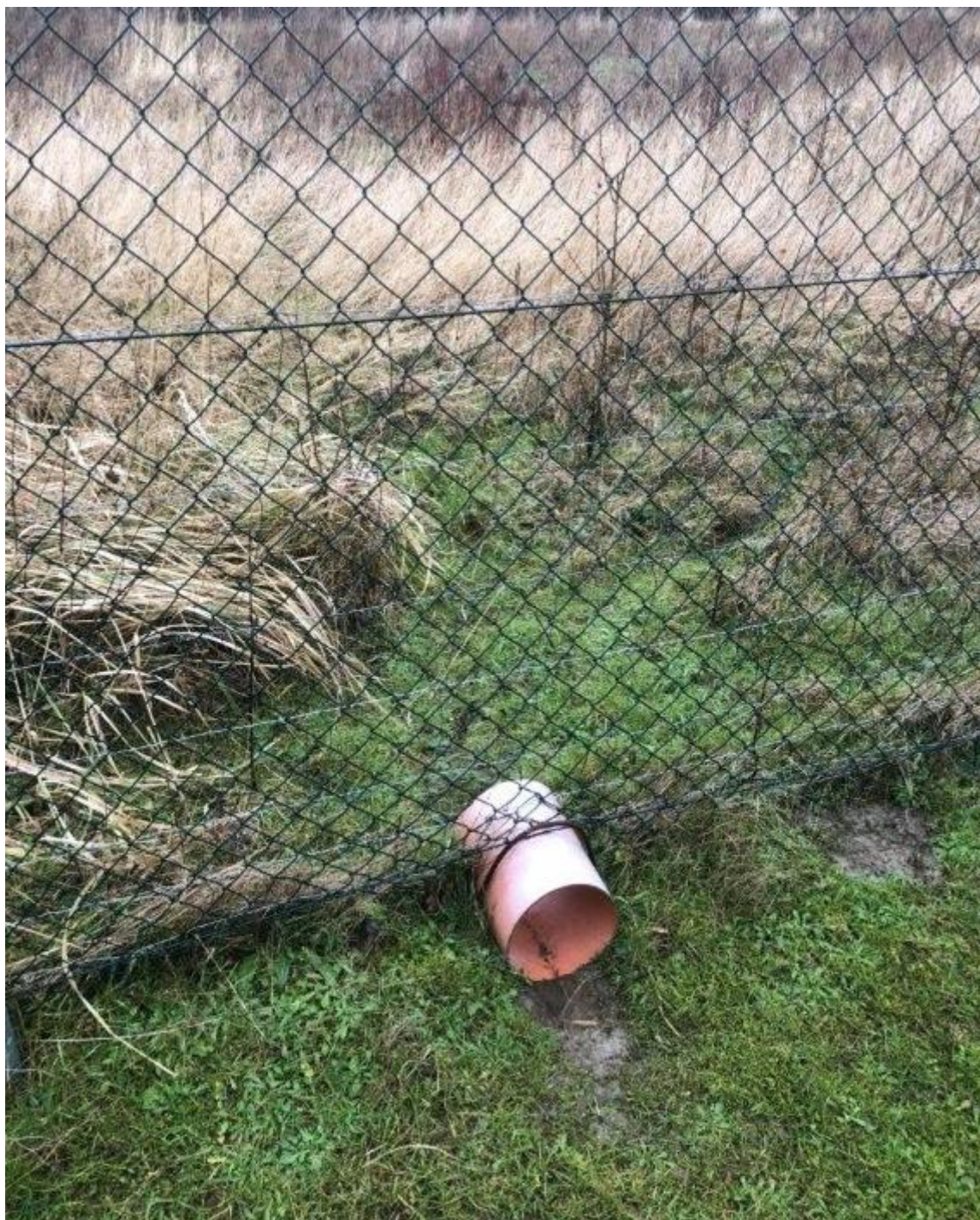
Abbildung 7: Einfriedung mit Öffnungen, um Durchgängigkeit für Kleintiere zu gewährleisten (Quelle: ENERPARC AG)
