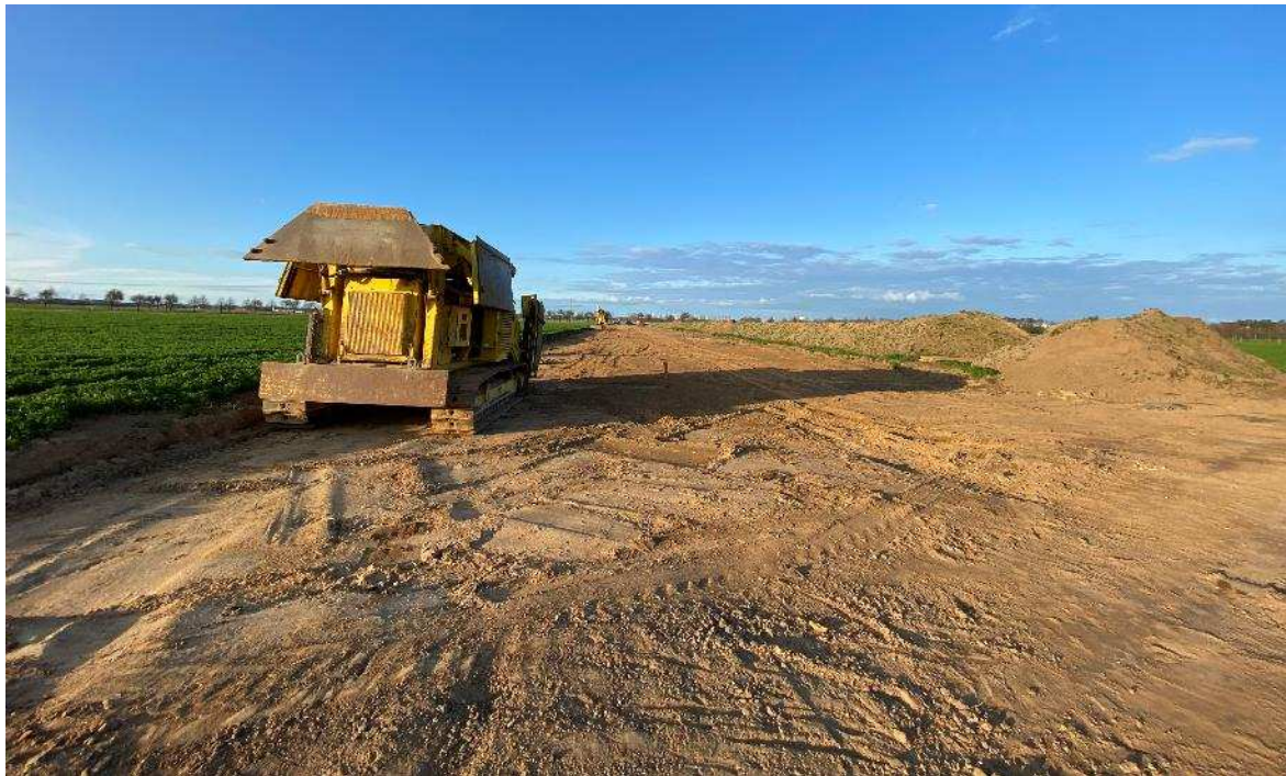
Abbildung 3 Erneuerung der Ferngasleitung im Untersuchungsgebiet (Abschluss Baumaßnahmen Mitte/Ende April 2024)
