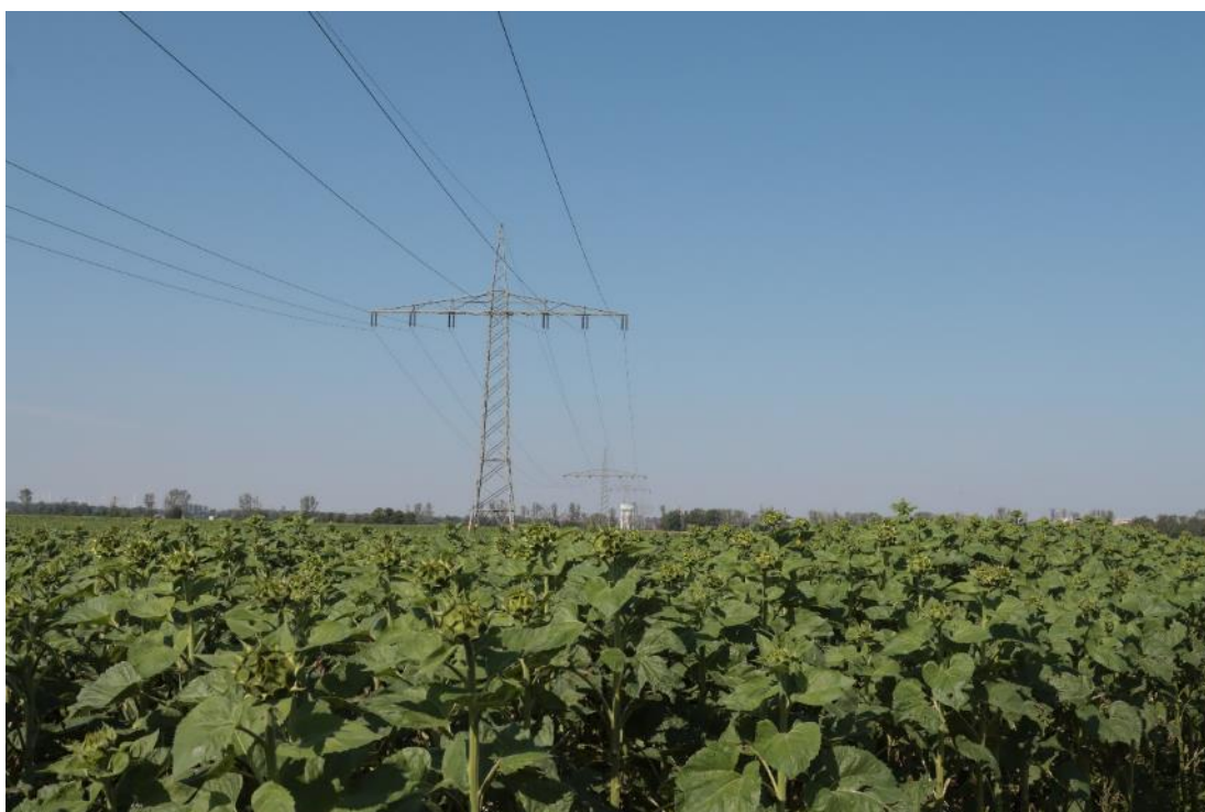
Abbildung 30 110-kV-Leitung inkl. Leitungsmast auf dem Flurstück 116 (FI001, Gemarkung Wainsdorf)
