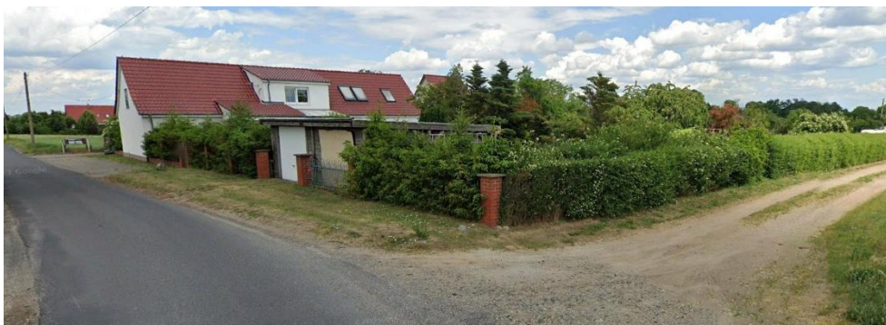
Abbildung 14: Blick auf den Anlieger Otto-Grotewohl-Straße 2 aus südlicher Richtung; Quelle Google Street View
