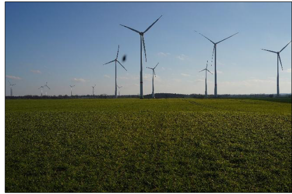
PA A, Blickrichtung Süden, Mitte November.
