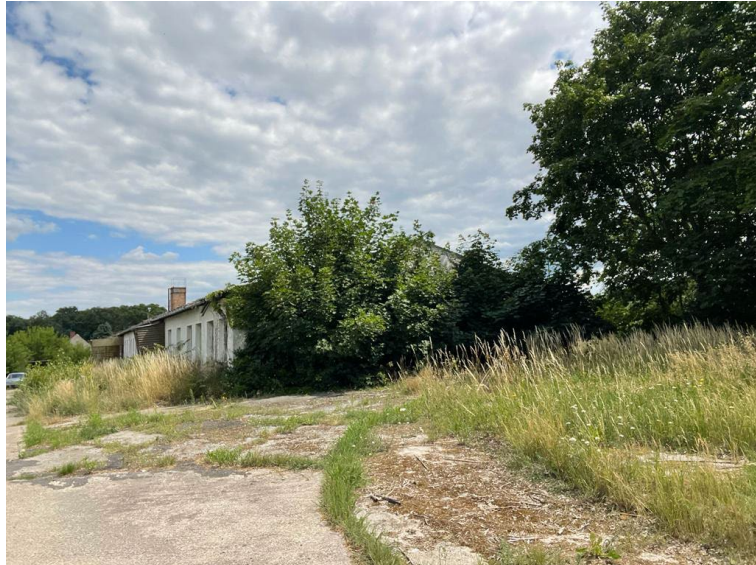
Grundstückzufahrt zum Verwaltungsgebäude BHG
