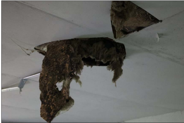
Abbildung 11: Die schwer zugängliche Zwischendecke im ehemaligen Bürogebäude könnte Potenziale für Fledermäuse als Sommer- oder Zwischenquartier bieten.; Aufnahme 05/2024
