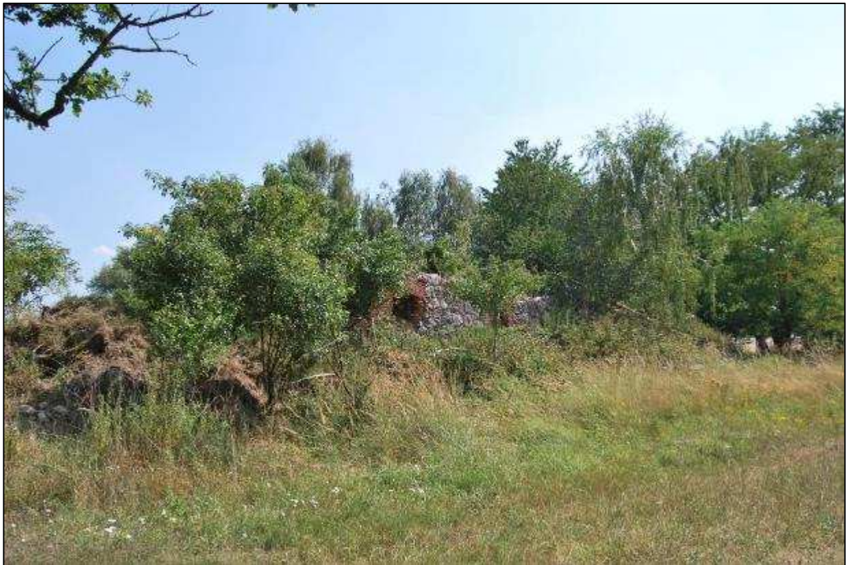
Abbildung 13: Ruine von Nordwesten
