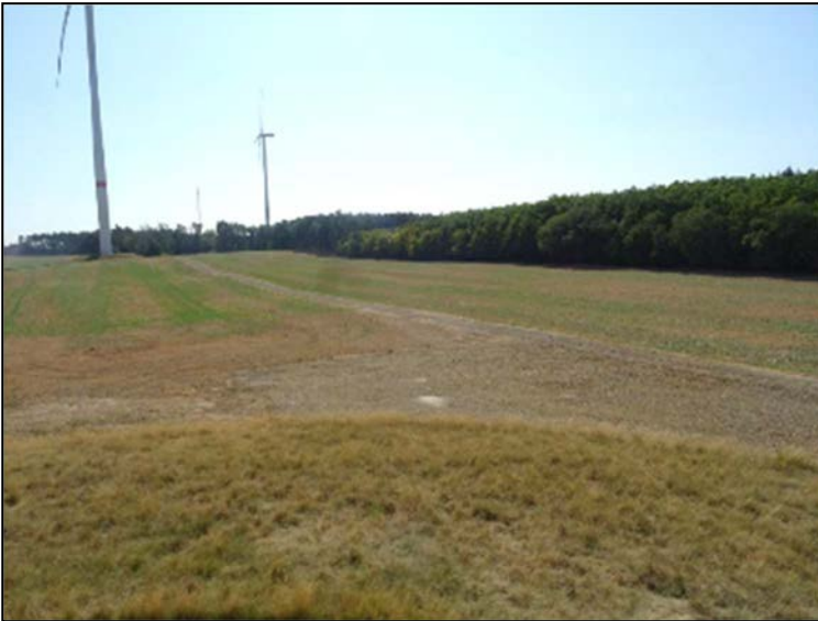
Abbildung 35: Neu angelegter, geschotterter Feldweg als Zuwegung zu im Herbst 2022 errichteten WEA im Süden der VHF
