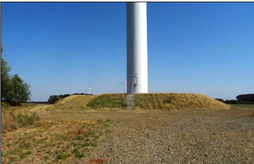
Abbildung 32: Im Herbst 2022 errichtete WEA auf Acker im Süden der VHF
