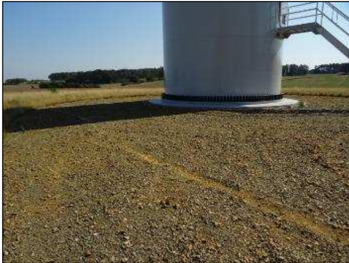
Abbildung 9: Geschottertes, vegetationsfreies Plateau des Fundaments einer im Herbst 2022 errichteten WEA
