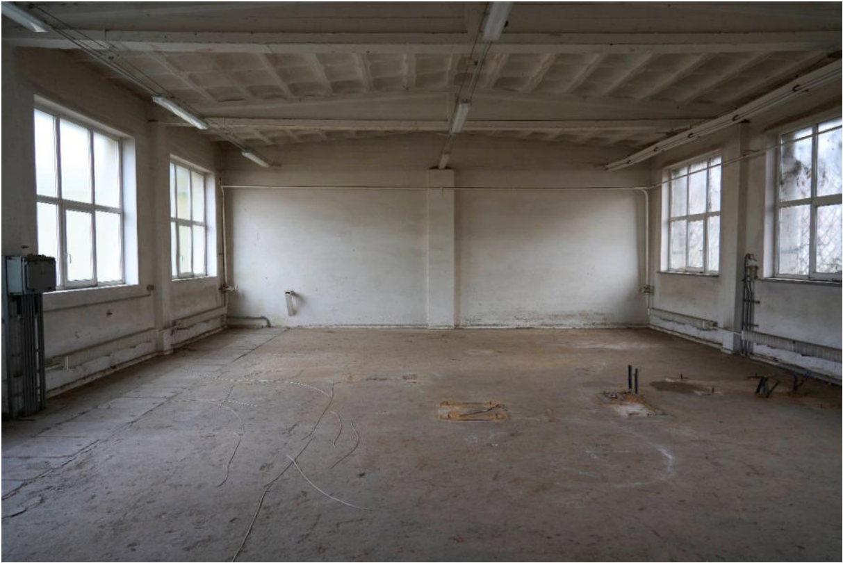
Abbildung 21 Flachbau im Norden von Innen
