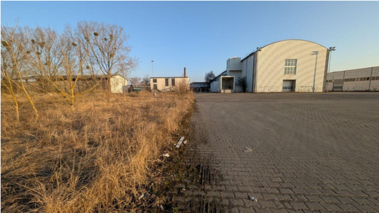
Abbildung 23 Blick über die versiegelte Zufahrt zu AWU in Richtung Industriehallen
