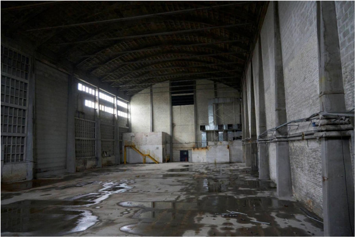
Abbildung 12 größere Industriehalle Blickrichtung Süd
