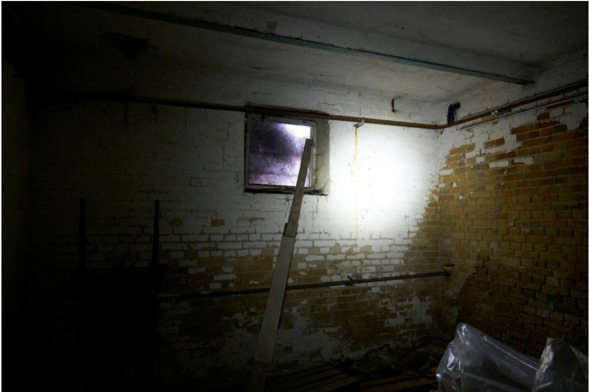
Abbildung 17 Keller im Wohn-/Bürogebäude
