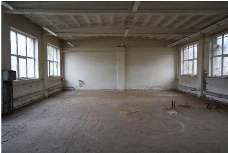
Abbildung 7: Innenräume Produktions- und Lagerhalle
