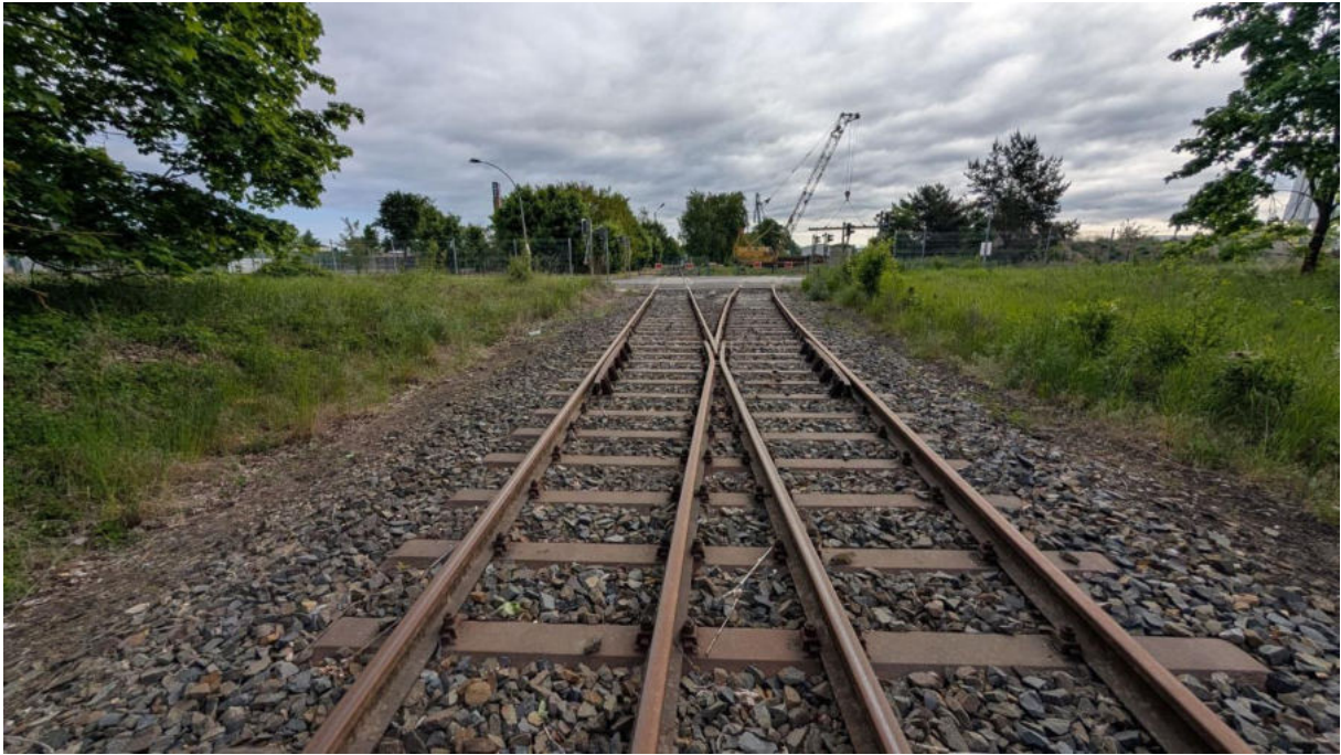
Abbildung 29 die alte Gleisanlage im Osten des UG (11.05.2025)
