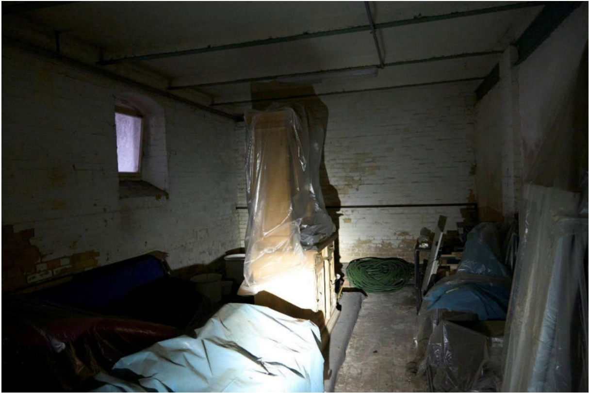
Abbildung 19 Keller im Wohn-/Bürogebäude
