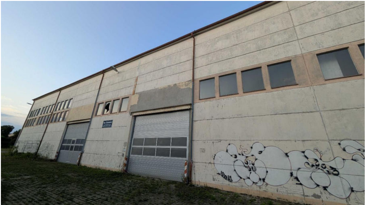
Abbildung 7 Die kleinere Industriehalle Ansicht aus Ri West
