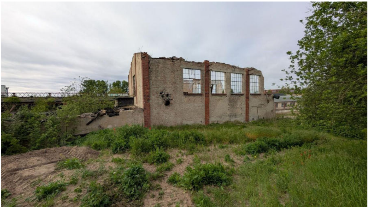
Abbildung 26 Ruine im Norden des UG
