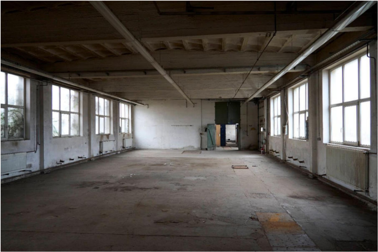
Abbildung 22 Flachbau im Norden von Innen
