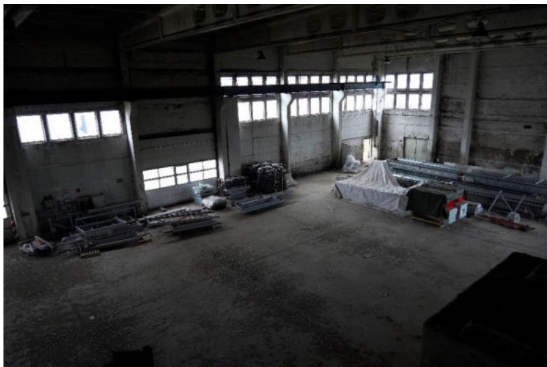
Abbildung 8: Innenräume Produktions- und Lagerhalle
