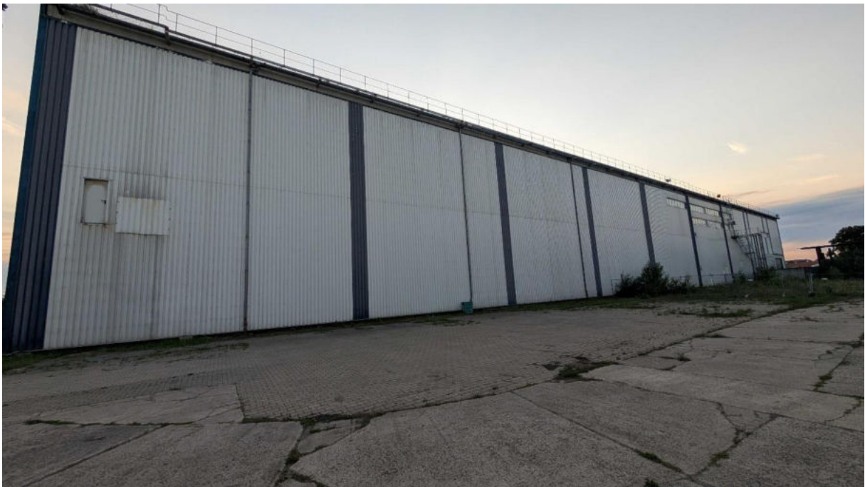
Abbildung 8 Die größere Industriehalle Ansicht aus Ri Ost
