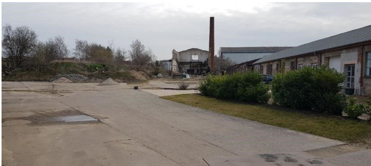
Abbildung 3: Ehemalige Produktionshallen im nördlichen Bereich
