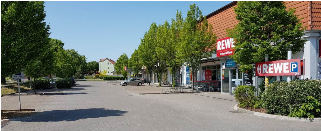
Abbildung 3: REWE-Markt mit straßenbegleitenden Parkflächen von Südosten
