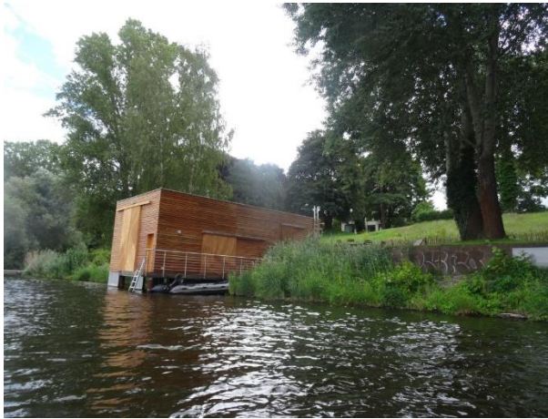
Bootshaus im Südosten des Griebnitzsee
