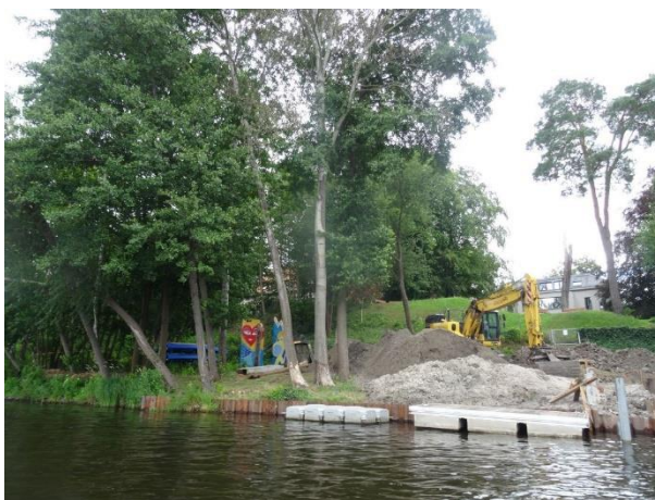
Als Baustellenbereich kartierte Uferzone im Süden des UG
