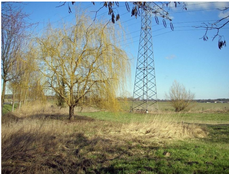
Abb. 12: Der Hochspannungsmast auf dem Grundstück an der Landstraße L 166 der als Netzverknüpfungspunkt dienen soll. Er trägt die beiden 110 kV Hochspannungsleitungen Friesack - Kyritz 3 und Wustermark - Neustadt 2 . (Foto RIK: P1010037.JPG_2023)
