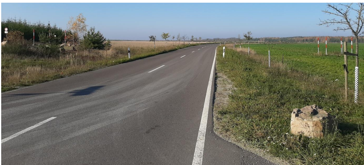
Abbildung 10: Betriebsstraße LEAG (Verbindungsstraße zwischen Papproth und Spremberg)
