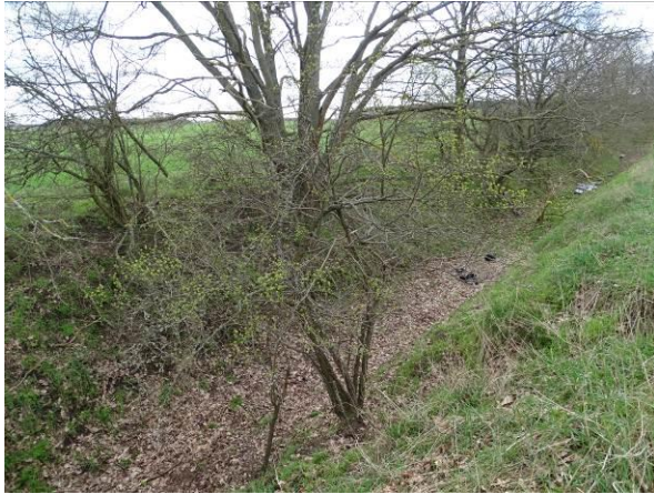
Abbildung 29: ausgetrockneter Graben im Norden (April 2023)
