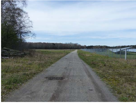
Foto 7: Wander-/ Radweg und Photovoltaik-Freiflächenanlage im Plangebiet
