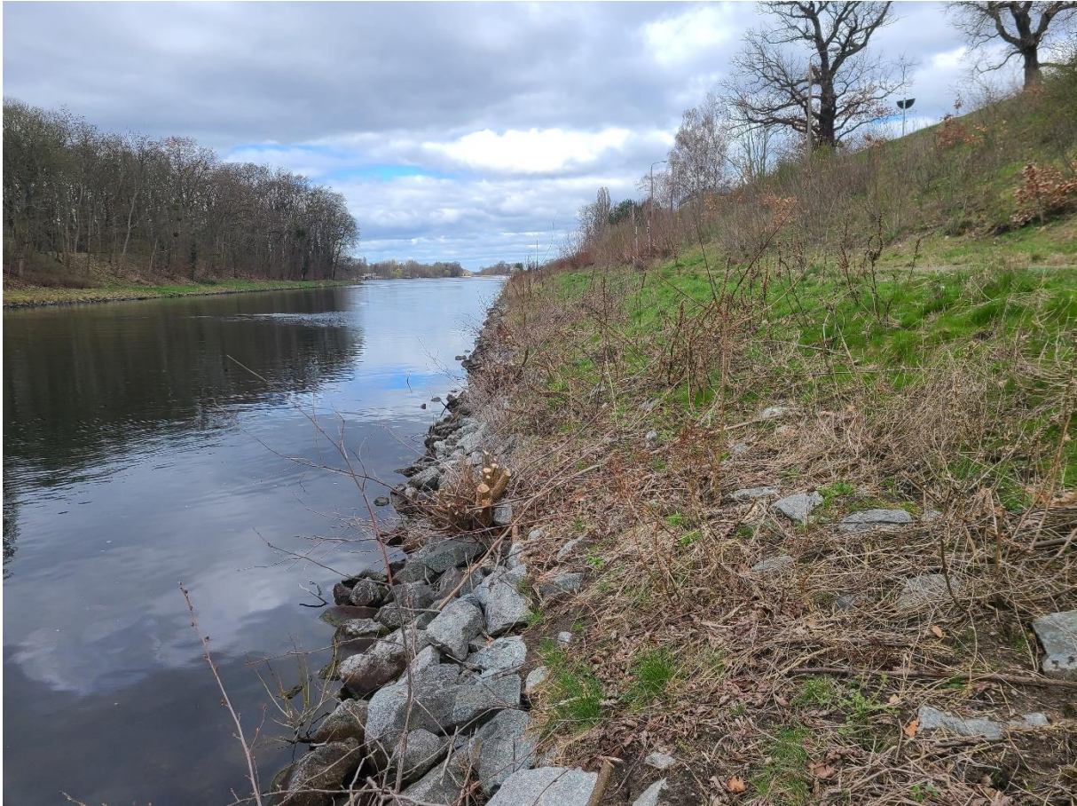
Abbildung 2: Sacrow-Paretzer-Kanal mit steiler Böschung aus geschütteten Wasserbausteinen, hier erfolgte kürzlich eine Mahd/Freischnitt
