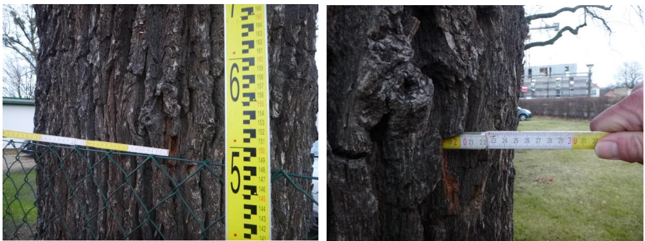
Abbildung 10: Fäule Stammseite, südlich
