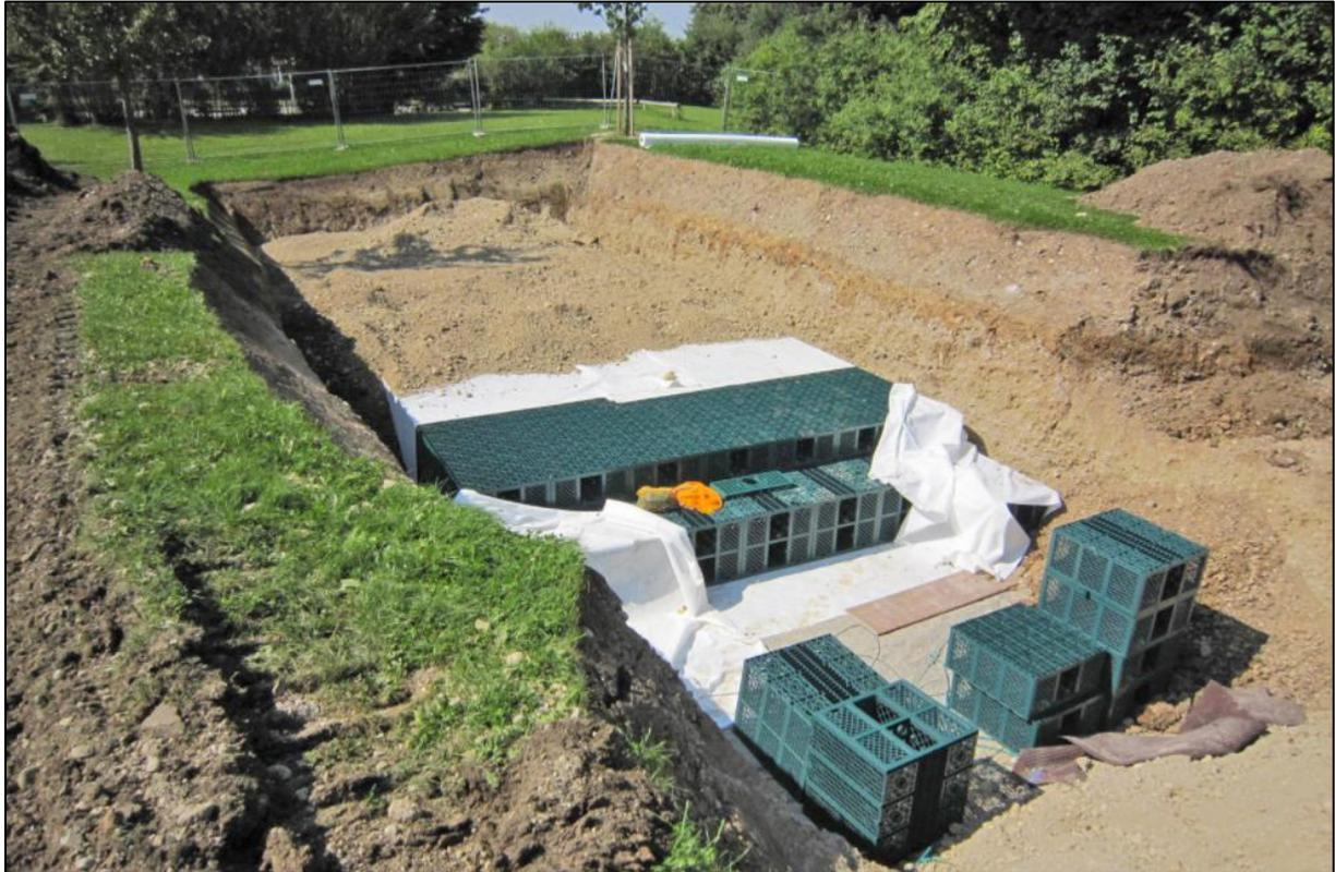
Abbildung 14: Ausführungsmöglichkeit einer Füllkörperrigole [Quelle: <https://www.energiesystemtechnik.de/images/referenzen/aying-gs/aying-gs02.jpg/>, 22.01.2021]
