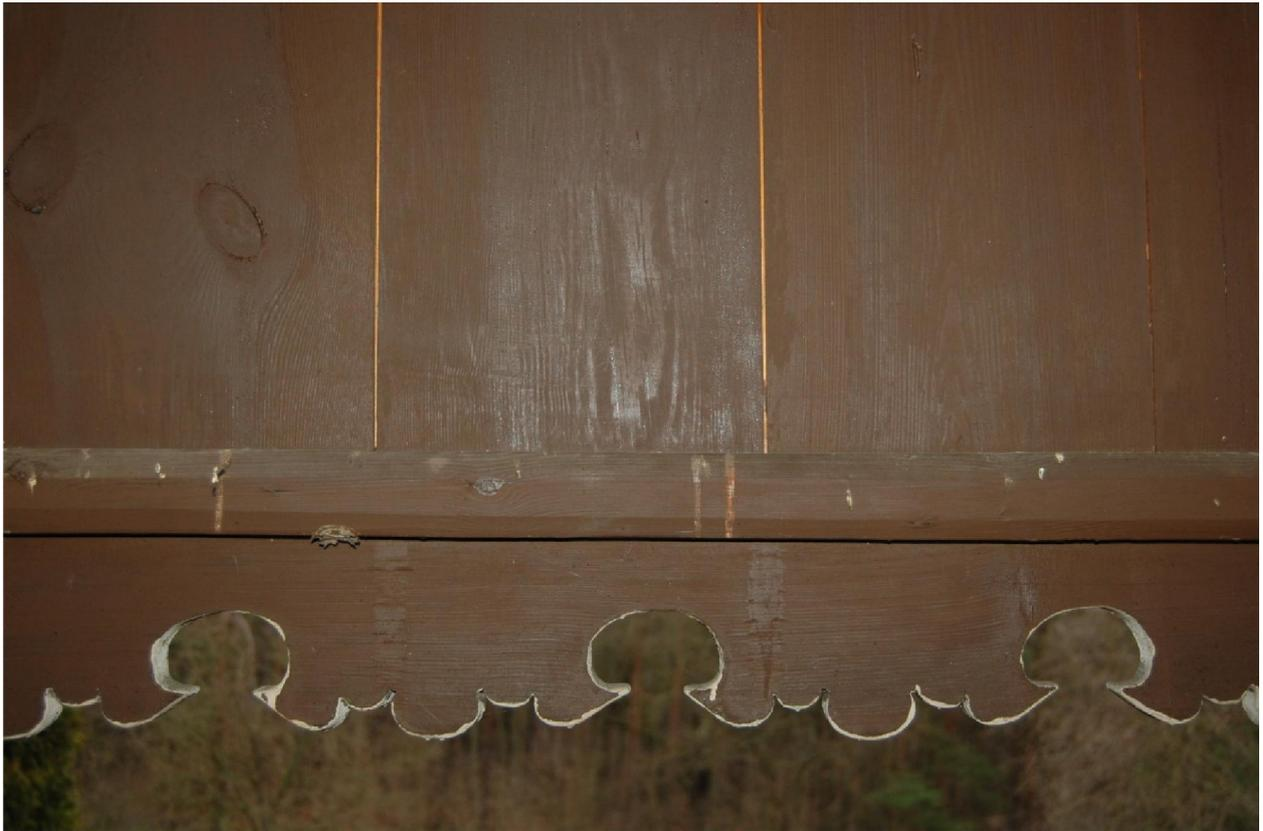
Abb.; <sup>55</sup> Foto Duras; Februar 2016; Fassade Nord, Detail Schleierbrett mit Zier, Innenansicht
