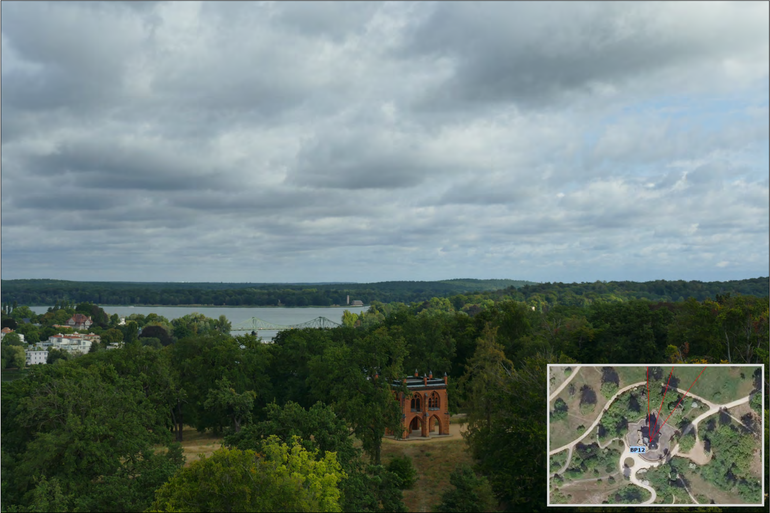
BP12 - Babelsberg, Flatowturm - Istzustand
