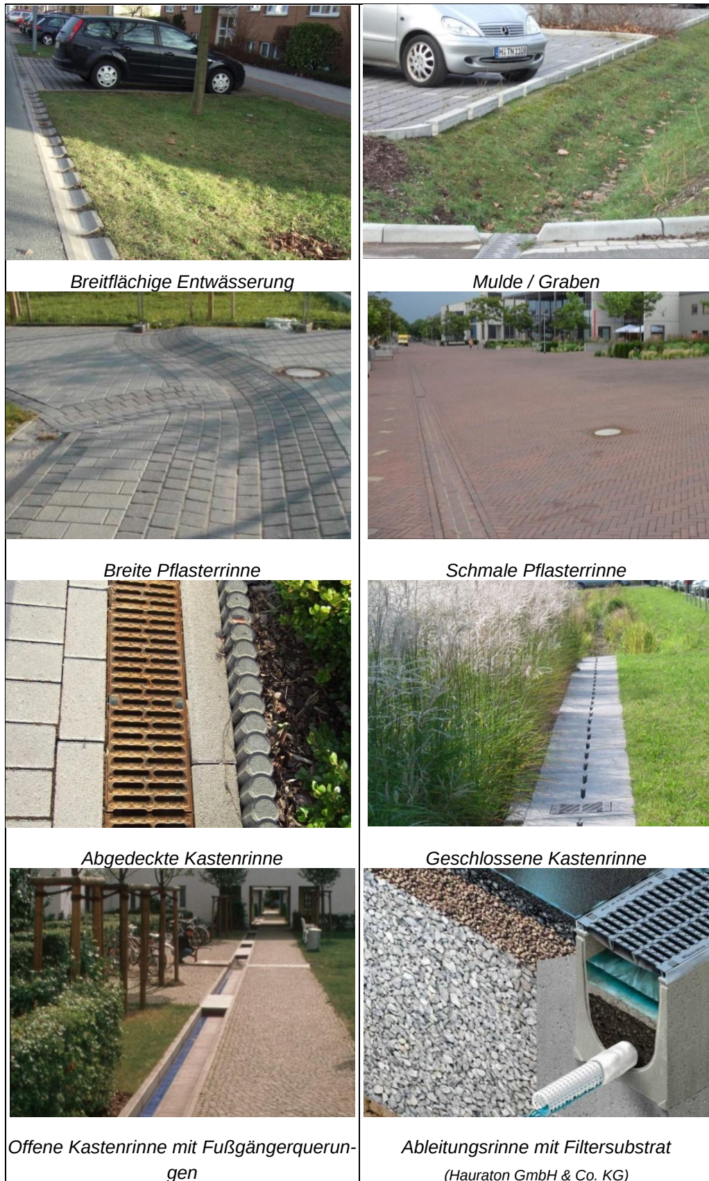
Bild 2-5: Beispiele oberirdischer Ableitungssysteme
