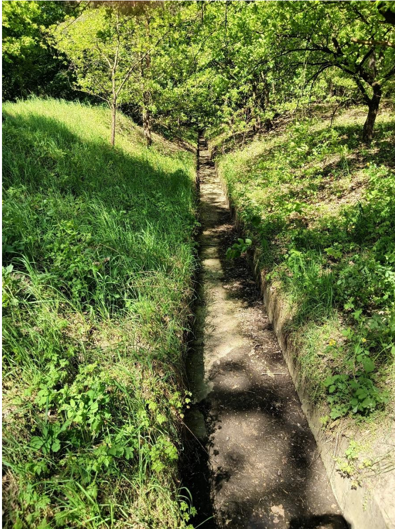
Abb. 5: Rehpfuhlgraben in Betonschalen, trockengefallen
