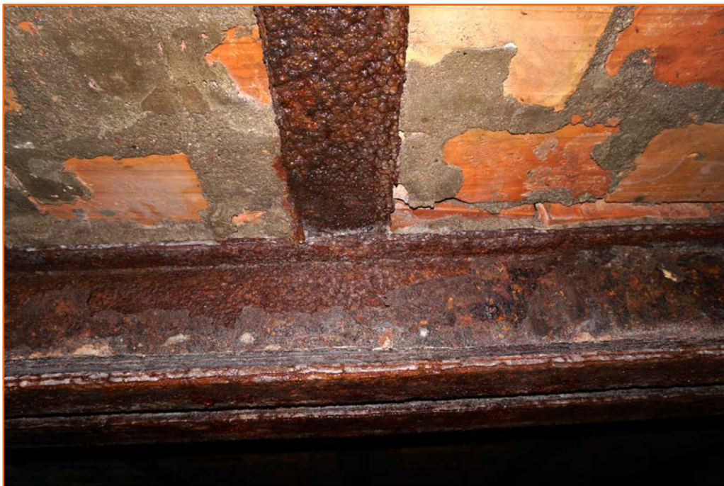
Abb. 19: Vor Beginn einer Optimeirung des Winterquartiers ist eine statische Prüfung erforderlich.
