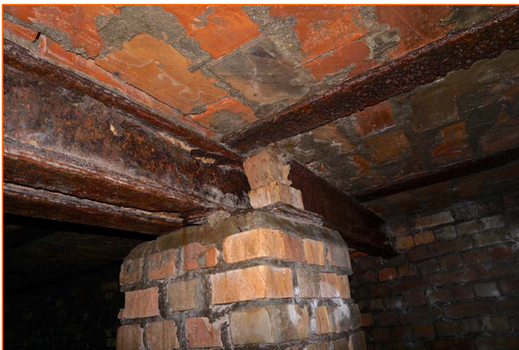
Abb. 17: Der Keller ist für eine Optimierung zu einem vollwertigen Fledermauswinterquartier gut geeignet. Vor Maßnahmenbeginn ist die Statik des Objekts zu prüfen.
