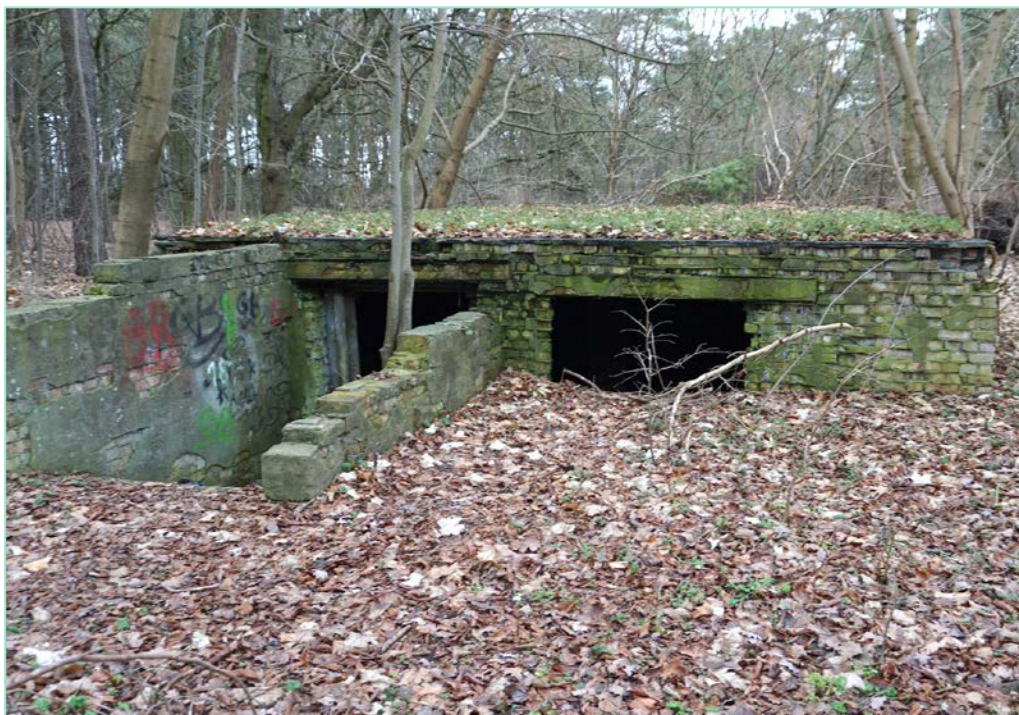
Abb. 11: Das Fledermauswinterquartier liegt direkt an der Grenze des Plangebiets. Durch die großen Öffnungen ist das Quartier nicht vollständig frostsicher und nicht gegen Störungen gesichert.
