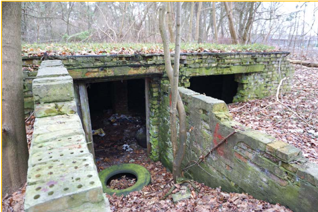
Abb. 14: Der Keller ist durch große Öffnungen witterungsexponiert und ist daher nicht vollständig frostsicher.
