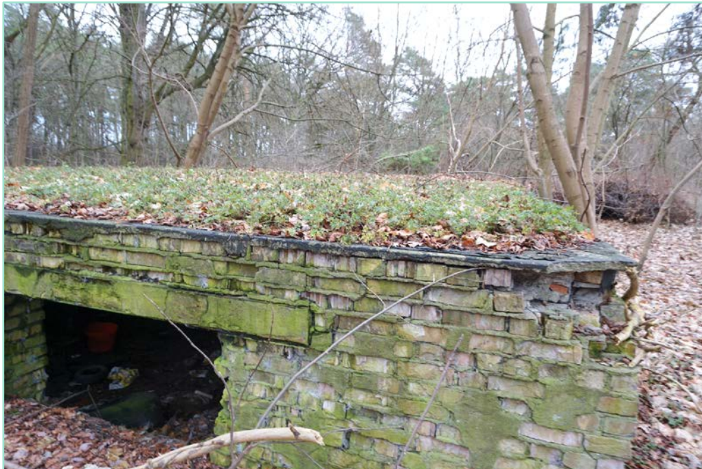
Abb. 20: Die großen Öffnungen sind zu verschließen, um den Keller gegen Störungen zu sichern und das Raumklima zu optimieren.
