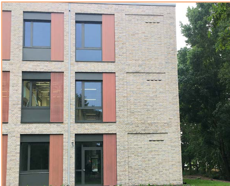
Abb. 31: Integration von Fledermaus- verstecken (Fledermauseinlaufblende 1FE) in das Gerty-Cory-Haus, Deutsches Institut für Ernährungs- forschung in Potsdam-Rehbrücke (Foto: DIfE 2021).
