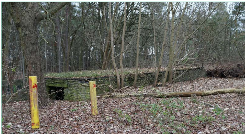
Abb. 5: In dem ungenutzten Keller wurden am 18. Dezember 2024 überwinternde Fledermäuse gesucht. Der Keller liegt direkt an der Grenze des Plangebiets.
