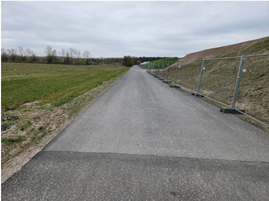
Abbildung 6-9: Asphaltierter Weg östlich des Teilgebietes 1, Blickrichtung Süd (11.04.2025)
