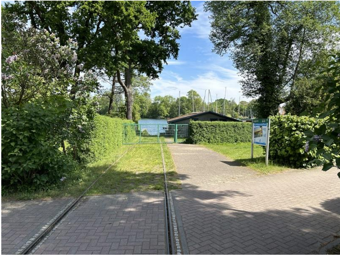
Bild 13: Blick von Westen auf Bootshaus (Flst. 72) am Scharmützelsee
