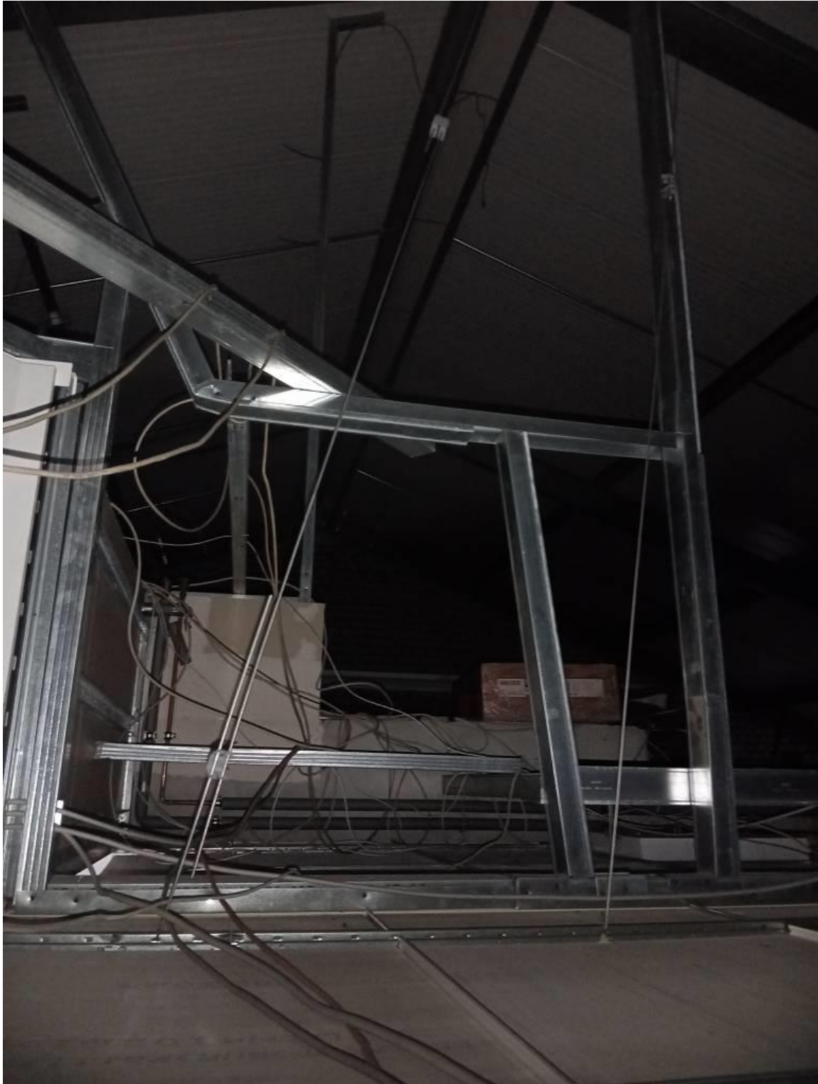
Abbildung 10 Blick hinter die Deckenplatten
