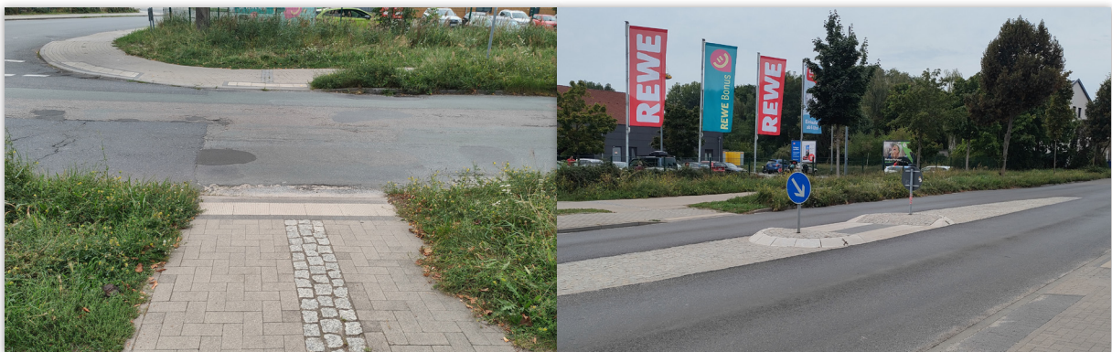
Abbildung 2-4 Bestehende Querungsanlagen | KP Karl-Marx-Straße / Goethestraße
