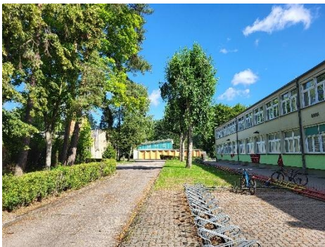
Abb. 6: Zufahrt zum Schulgelände mit Blickrichtung Sporthalle und Heizhaus
