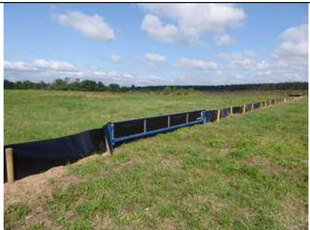
Foto 18: Beispiel für einen Reptiliensperrzaun (hier mit Tor) (Foto: Wiesner)
