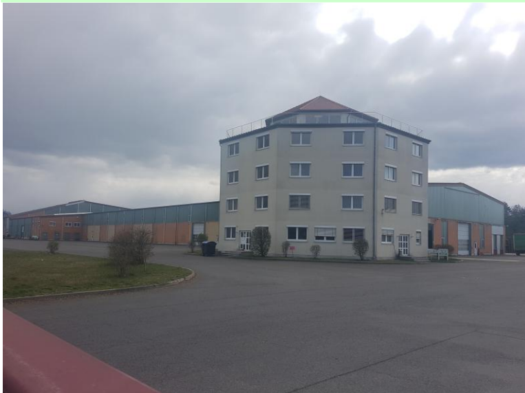
Abbildung 6: die Halle (1) mit Lagerflächen (2) von der Zufahrt nach Osten fotografiert
