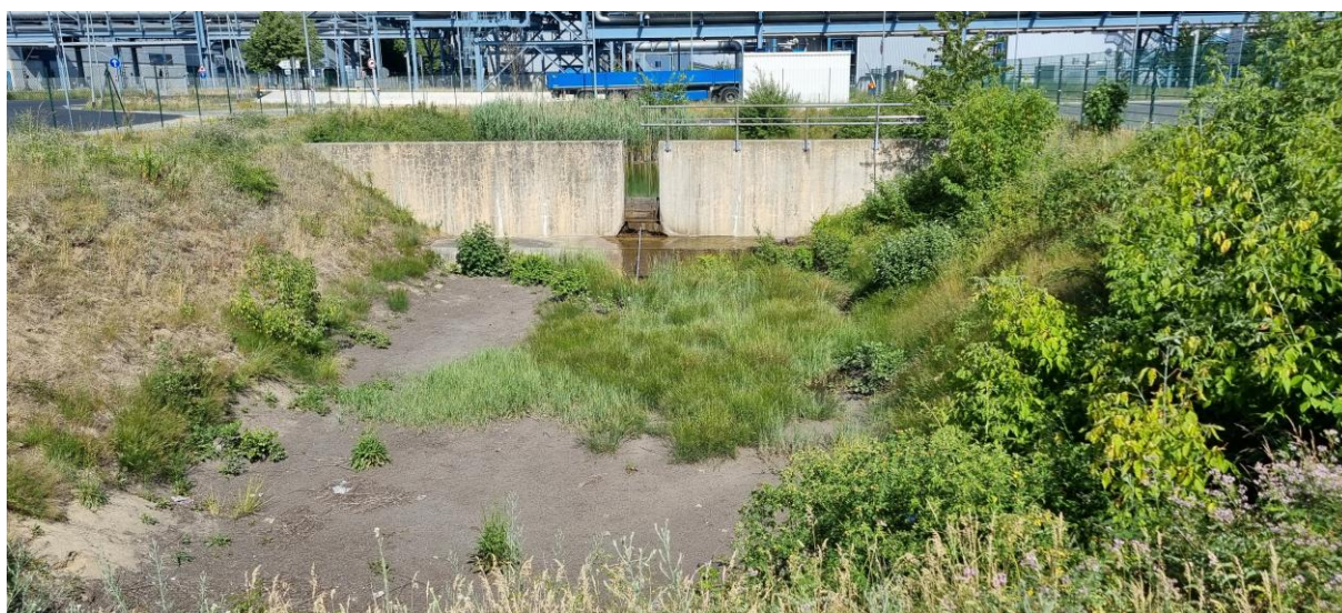
Abbildung 10: Gewässer (A) das befestigte Entwässerungsbecken im Nordosten führt nur temporär Wasser
