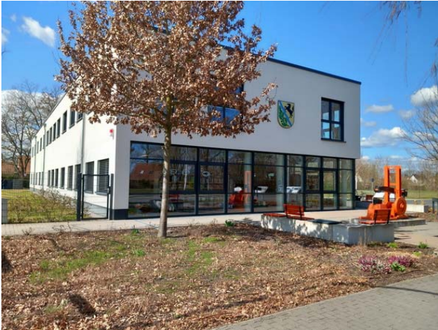
Blick von Südost zum südlichen Flügel des Rathauses mit Bibliothek
