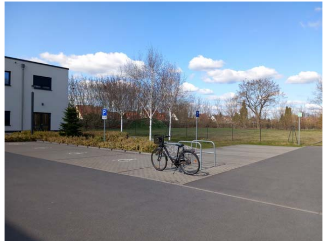
Blick von Ost zu den Fahrradstellplätzen und Behindertenstellplätzen vor dem westlichen Flügel des Rathauses
