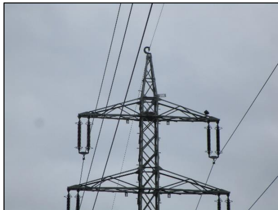
Abbildung 18 Horst des Kolkraben auf der Traverse einer 110-KV-Hochspannungsfreileitung
