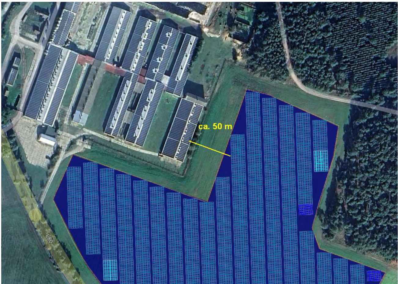
Bild 2.2.1: Gebäude nördlich der PV-Anlage (Quelle: Google Earth/SolPEG)
