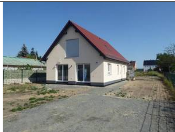
Foto 3: Wohnhaus im Süden des Flurstücks 452 (Foto: Wiesner, 9.6.23)
