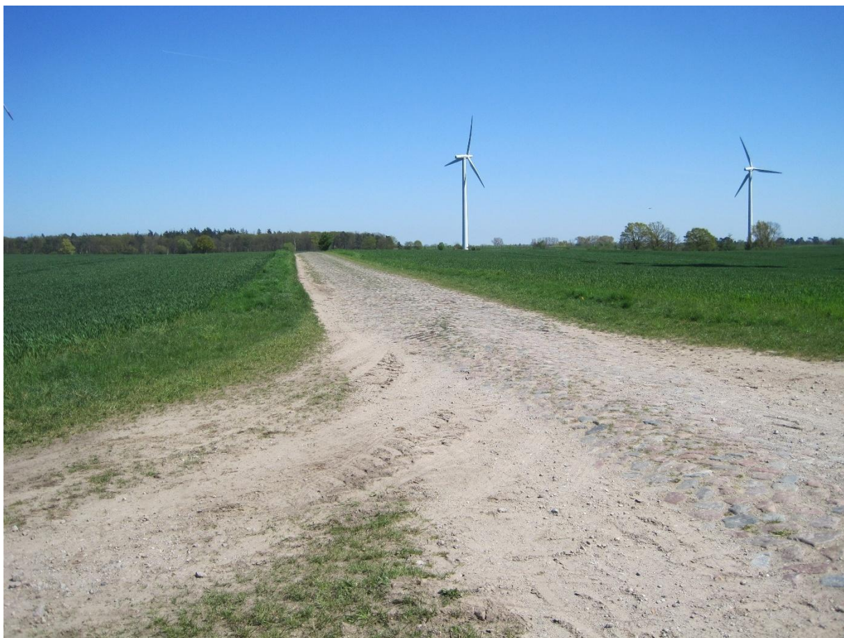
Abbildung 15: Verbindungsweg von der Gemeindestraße Hohen-Tutow/ Groß Luckow nach NeuhoF
