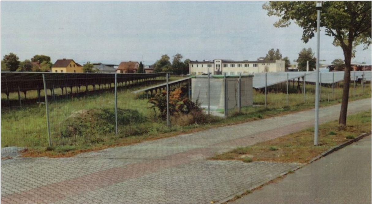
Blick vom Eingangsbereich der bestehenden Freiflächenfotovoltaikanlage an der Wedemarker Straße zur Anlage mit zugehöriger Trafo-/ Wechselrichter-Station. Die seit 2018 gewachsene Ruderalflur unter den Fotovoltaikpaneelen ist gut zu erkennen.
