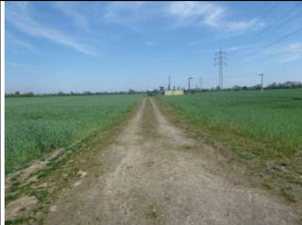
Foto 1: geschotterter Zufahrtsweg zum Umspannwerk (Foto: Wiesner, 20.4.25)
