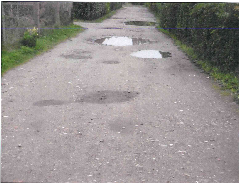
Foto 15: massiv mit Bauschutt befestigte Zufahrt (Flurstück 188)
