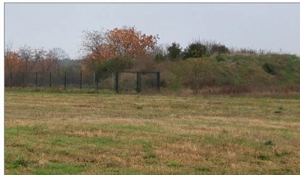
Abbildung 2.16: Lärmschutzwall zur B168 nordöstlich des Plangebietes
