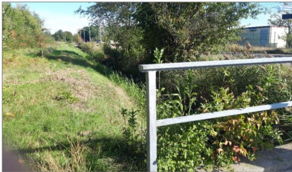
Abbildung 2.9: Branitz-Dissenchener Hauptgraben nördlich der Einmündung W-v-S-Straße in Branitzer Straße (011331)
