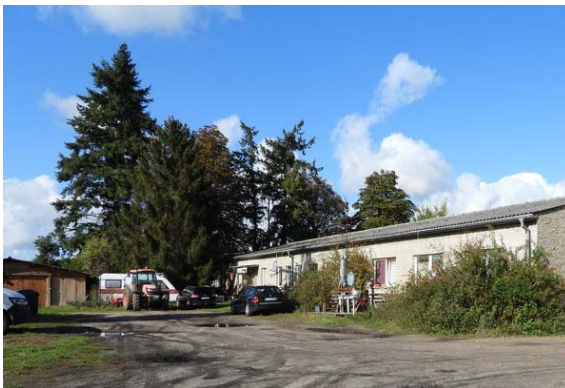
Unterkunftsgebäude südlich des Mittelweges nordwestlich des Plangebietes, Ansicht von Südost
