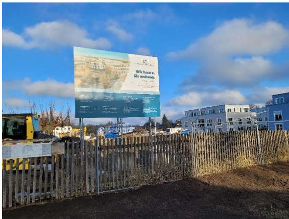
Abbildung 9: Wohnpark "An der Havelaue". Baustellenansicht (Nordosten)
