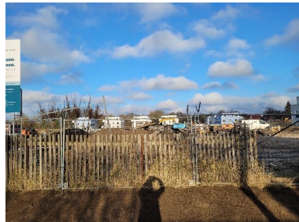
Abbildung 10: Wohnpark "An der Havelaue". Baustellenansicht (Norden)
