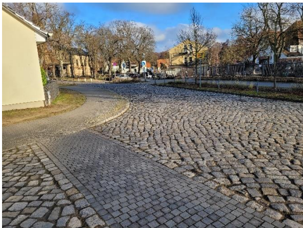
Abbildung 19: Havelstraße – östlicher Bereich (Norden)
