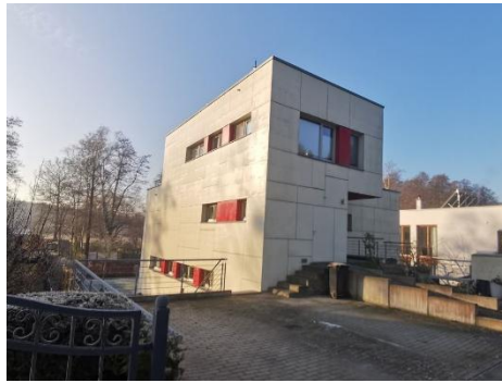
Abb. 5: Gebäude an der „Havelstraße“, Blickrichtung Süden
