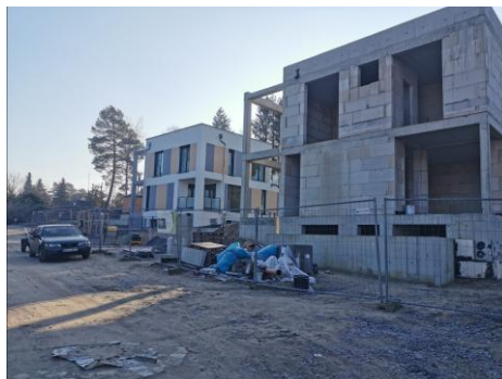
Abb. 15: In Bbau befindliche Wohngebäude am „Fischerwall/Wendenplan“, Blickrichtung Süden
