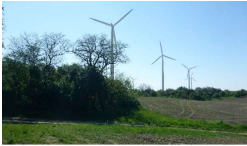
Abbildung 1: Windpark Podelzig-Lebus I mit angrenzenden Gehölzstrukturen einer ehemaligen Bahnstrecke sowie Feldwegen
