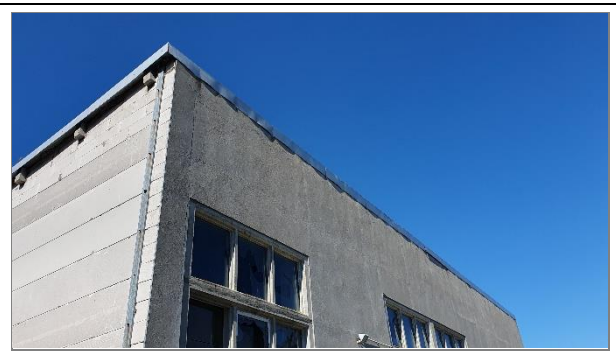
Abbildung 17: Attikablech am Dach
