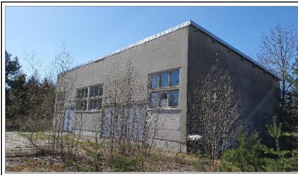
Abbildung 16: Lagerhalle (Gebäude 3), Ostseite
