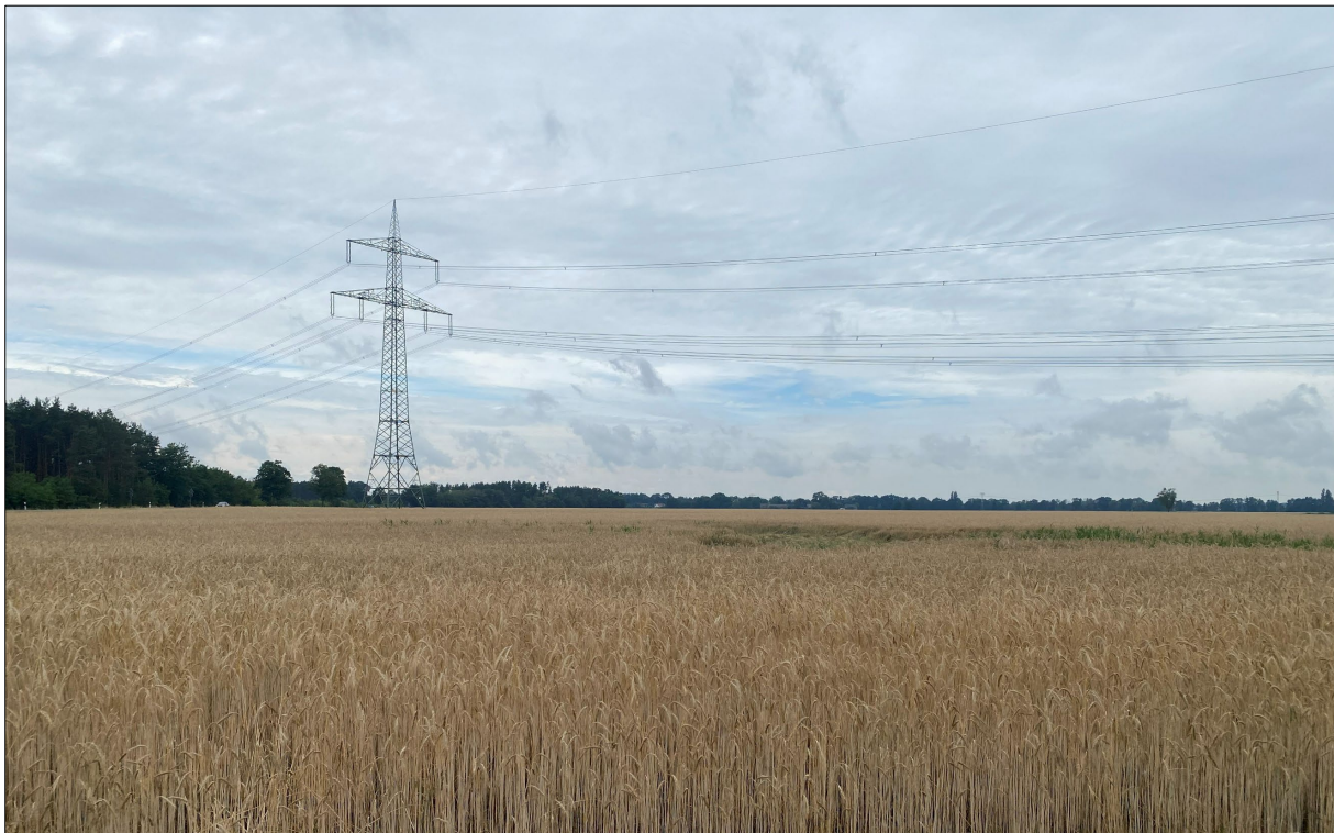
Abb. 11 im Süden des Plangebiets befindliche 380-kV-Leitung
