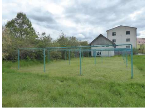
Foto 2: Wäscheplatz und Trafostation (Foto: Wiesner, 24.4.23)
