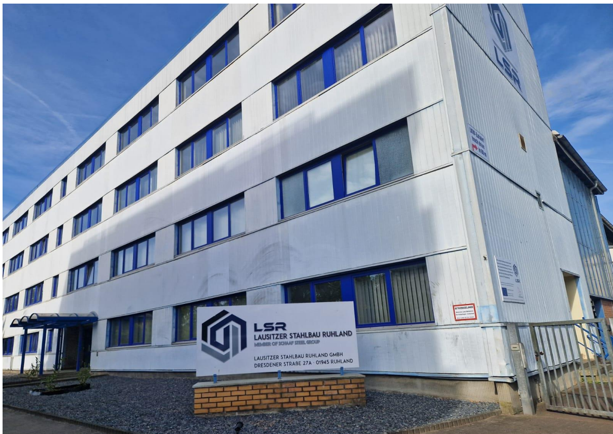
Abbildung 11: Verwaltungsgebäude Lausitzer Stahlbau Ruhland
