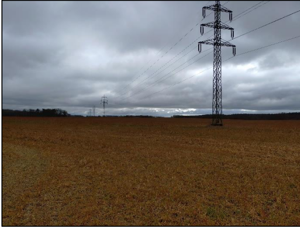
Abbildung 2: Fotografie von Nordwesten des Geltungsbereichs (Orangener Pfeil in Abbildung 1) – Hochspannungsfreileitung von West nach Ost (Kyritz nach Perleberg)
